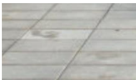
Fliser lagt i 0-forbandt
